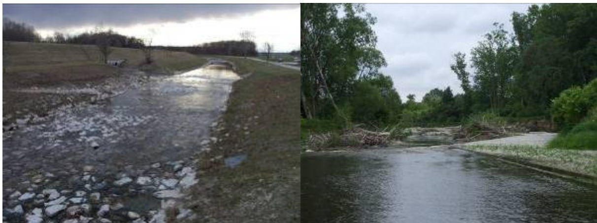
Abb. 4-58: Bild links: Mittellauf der Leitha: Begradigte Restwasserstrecke bei Lichtenwörth, wenig variable, anthropogen überformte, morphologische Ausformung (links im Bild: Damm des Rückhaltebeckens Lichtenwörth) Aufnahme: 07.02.2008, ezb; Bild rechts: Mittellauf der Leitha: variabel ausgeformte Restwasserstrecke bei Landegg mit Totholzansammlungen, Uferanbrüchen, Furt-Kolk-Abfolgen, Aufnahme: 19.05.2008, ezb
