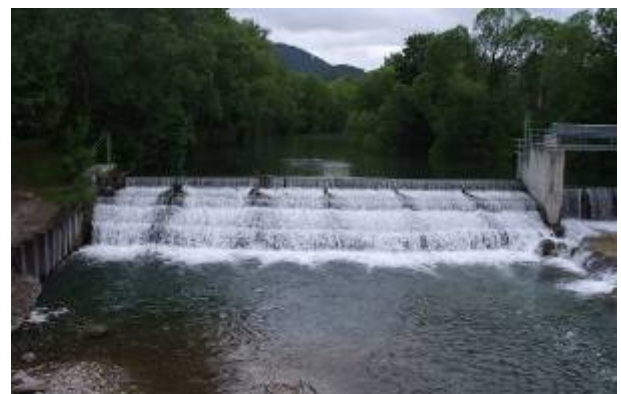
Abb. 4-64: Querbauwerkstypen im Projektgebiet. Bild links: Pegel als Beton – Sohlgurt in der Leitha bei Zillingdorf; Bild rechts oben: Sohlstufe in der Schwarza bei Ternitz – Putzmannsdorf; Bild rechts unten: Wehr in der Schwarza bei Gloggnitz bei Ausleitung Stuppacher Werkskanal
